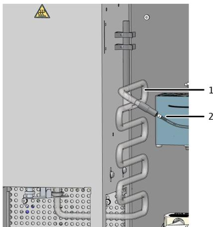
Fig. 11 Serpentín de condensación
